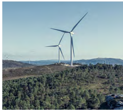
Parque eólico ALTO DA CROA II
