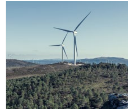
Parque eólico ALTO DA CROA II
