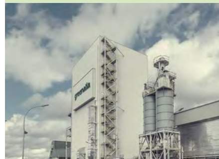
Equipo operativo en Planta de Biomasa Curtis - Teixeira (50 MW)
